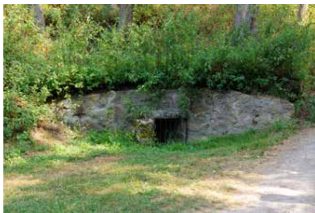
Fontaine située près de la passerelle de Pompairin.
